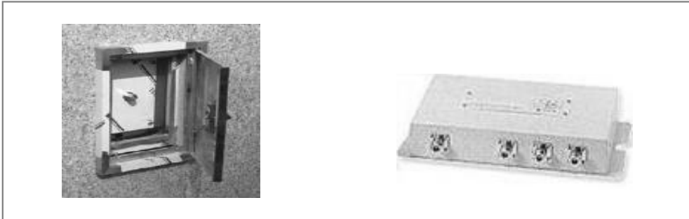
[그림 1-106] 무선기 접속단자함 및 분배기
