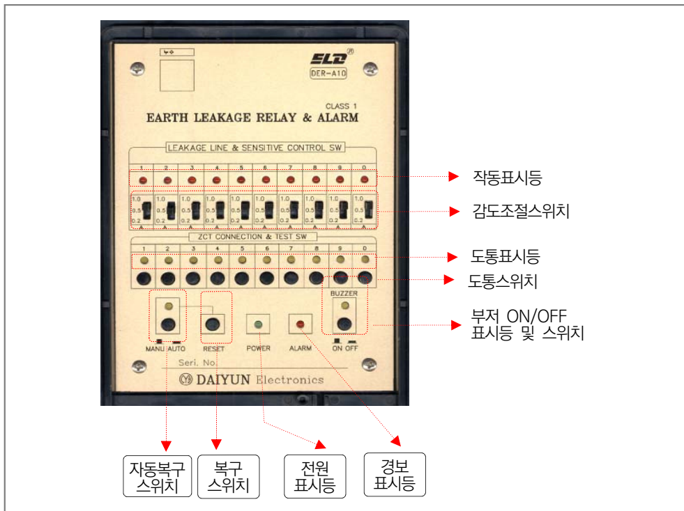
[그림 1-72] 누전경보기의 표시등 및 스위치
