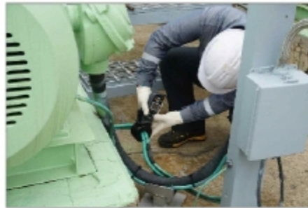
[펌프 접지저항 측정]
